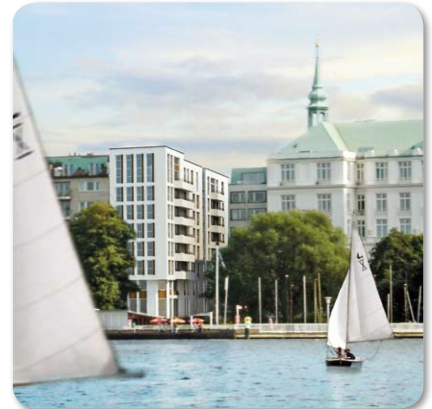
Auf dem Alstercampus entstehen rund 110 Wohnungen.
